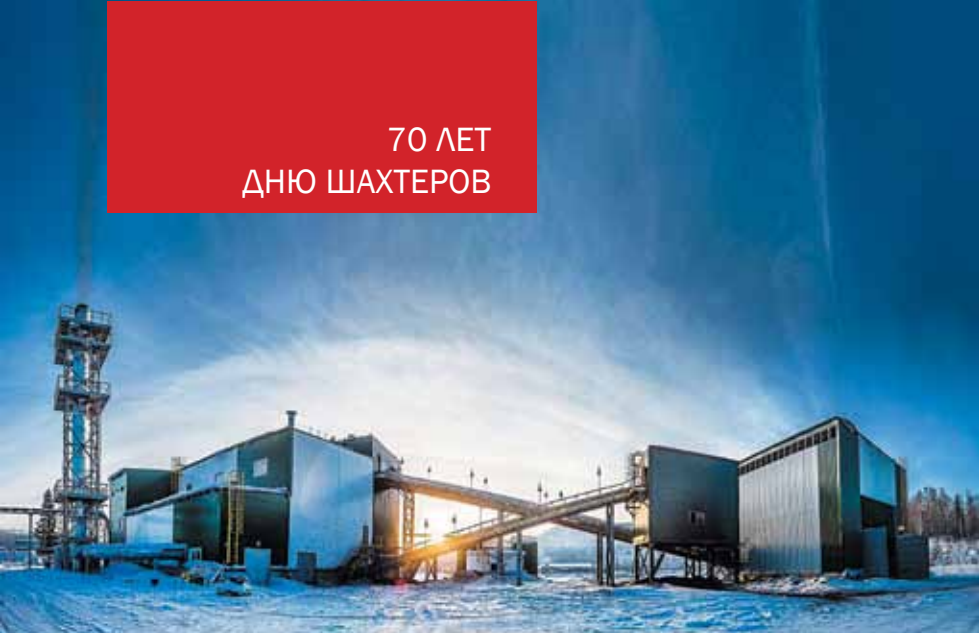
В январе позапрошлого, 2015 года компания «Кузбассразрезуголь» ввела в эксплуатацию обогатительную фабрику «Калтанская-Энергетическая»
